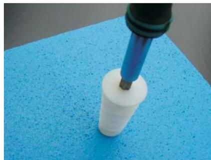
Danach mit dem Schraubendreher leicht und ohne großen Druck eindrehen, bis die Dübeloberfläche mit der Styroporfläche gleichmäßig abschließt.
