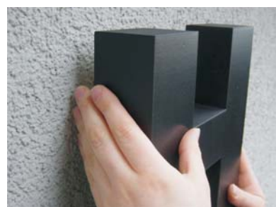
Den Buchstaben an die Wand drücken, so dass die Punkte für die Bohrung markiert werden
