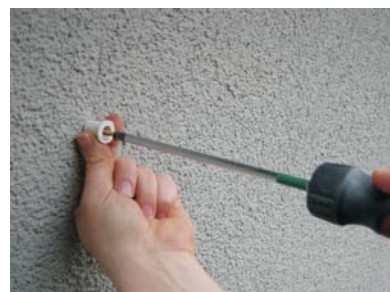
Distanzhalter A mit Schraube an der Wand befestigen
