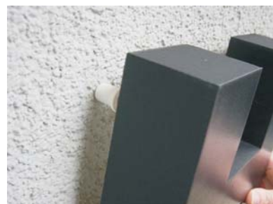
Distanzhalter A mit Schraube an der Wand befestigen
