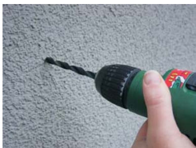
An den Markierungen Löcher bohren
